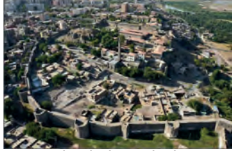
Diyarbakır Kalesi ve Hevsel Bahçeleri
